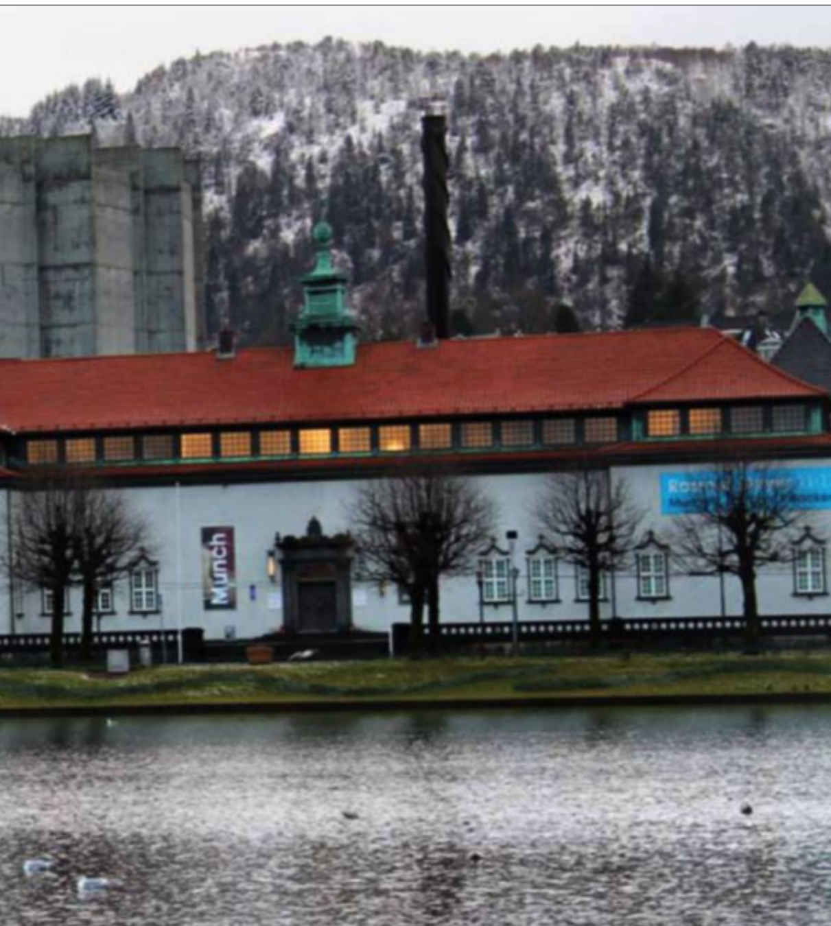
kommunen eller Grieghallen vil la ham male rett på byggene deres. Selv med garanti om at malingen lar seg fjerne. ILLUSTRASJON: LARS RAMBERG
